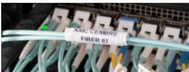
Die selbstklebenden Etiketten stellen eine schnelle, günstige und praktische Lösung für die Kennzeichnung von Leitern mit größeren Durchmessern dar.
